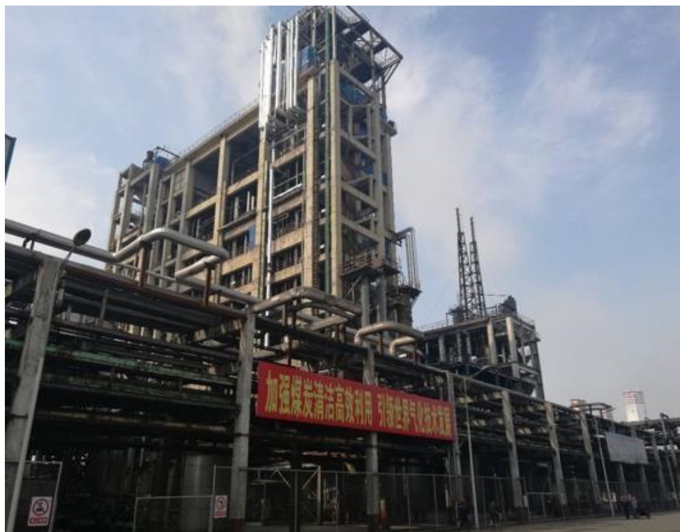
水煤浆水冷壁废锅气化炉示范装置
